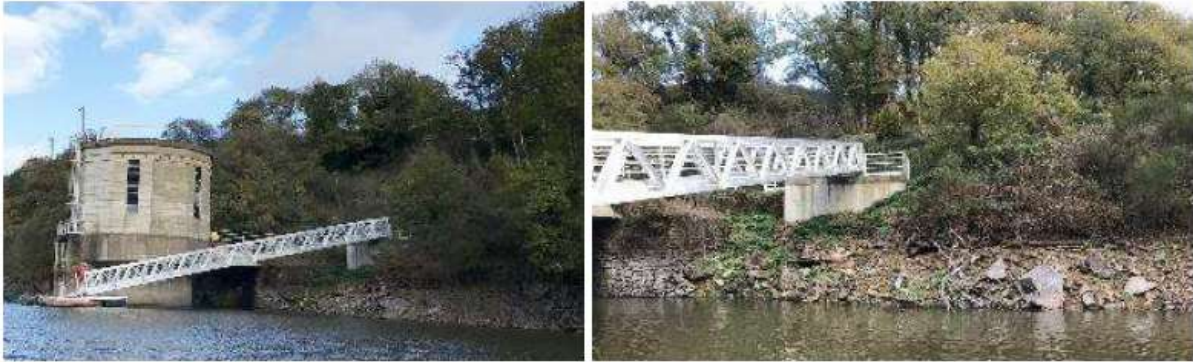
Figure 15 : Passerelle et ponton près de la tour d'exhaure, depuis la retenue et détail de la ripisylve (IDRA)
